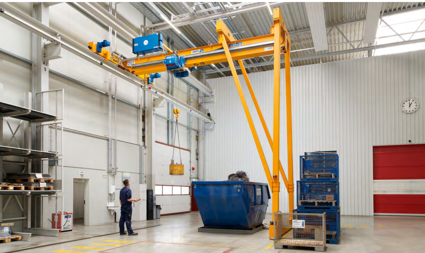
Semi-portique monopoutre avec treuil à câble électrique
